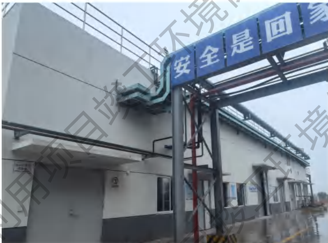
厂区生产废水处理站
