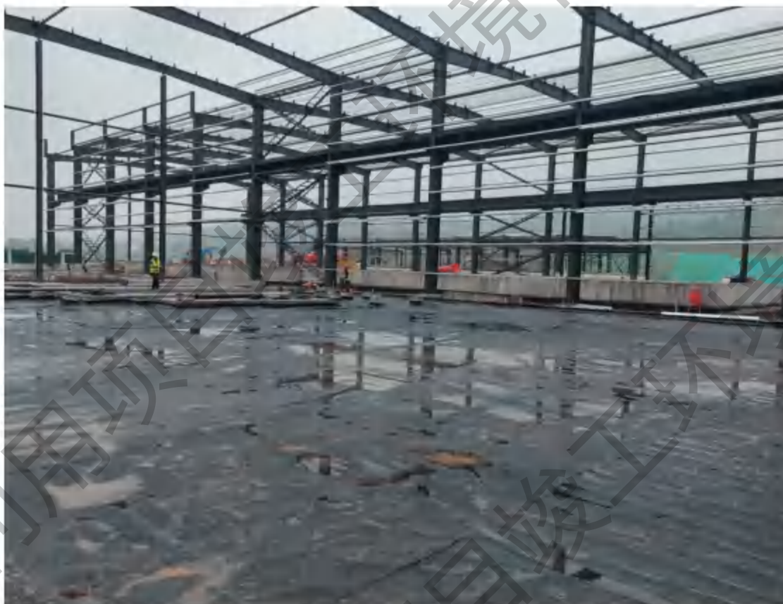
地下水分区防渗措施（油基岩屑暂存库）
