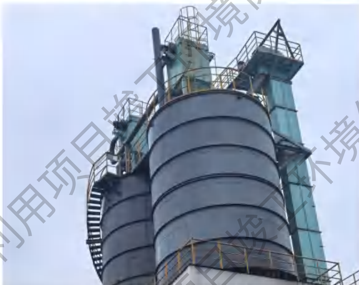
热脱附灰渣仓 ( 2 \times 350\text{m}^3 )
