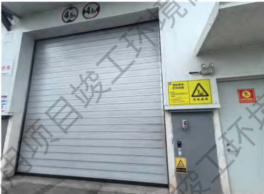
危险废物贮存库
