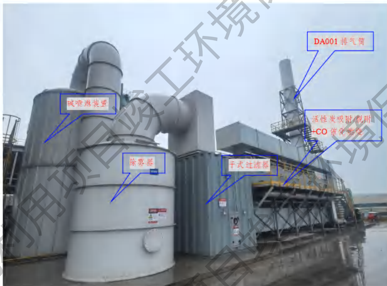
暂存库、卸料大厅等废气处理装置(碱喷淋+除雾器+干式过滤+活性炭吸附/脱附+CO催化燃烧+DA001 排气筒)
